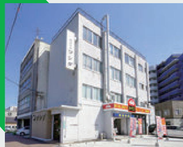
現在の社屋(2016年現在) 大規模なリフォームをしていますが、屋内には建築当時の社屋が残っている部分があります。
